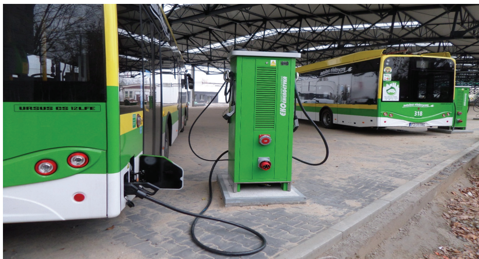
Rysunek 2. Ładowarka wolnego ładowania
